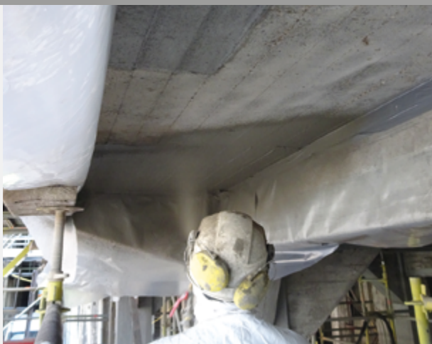
Application d'un revêtement inhibiteur de carbonatation.
