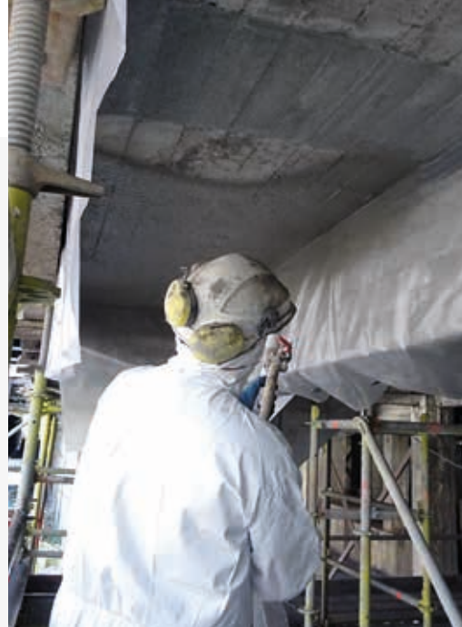
Projection d'un revêtement inhibiteur de carbonatation
