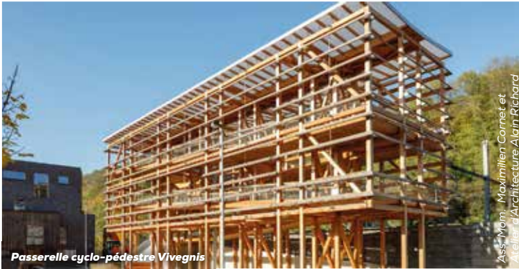
Passerelle cyclo-pédestre Vivegnis
