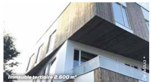
Immeuble tertiaire 2.600 m 2
