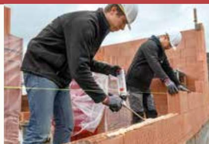
Avec Porothersm *Dryfix*, Wienerberger lance une technique révolutionnaire pour construire avec des blocs à coller PLS. La mousse en spray Porothersm *Dryfix* extra permet désormais de construire de façon encore plus rapide, plus qualitative et plus efficiente.
