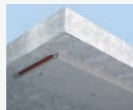
Protection au moyen de plâtre projeté
